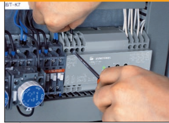
Bild 1: Zur Inbetriebnahme einer »Dimlite«-Lichtsteuerung reicht ein Schraubendreher
