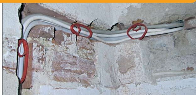
Dank der Fingerschleife lässt sich die Ellipse werkzeuglos und mit einer Hand in Mauerschlitz einsetzen und fixiert Kabel sicher in der Nut
